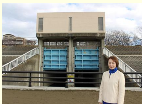
根川雨水幹線(六郷排水樋管)にて。土手天板の間近かまで多摩川の水位は上がった。
